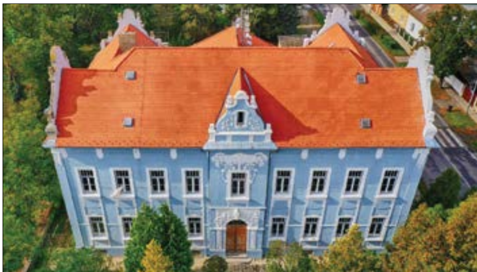
Oprava fasády bývalé školy, foto: Jiří Soukup
