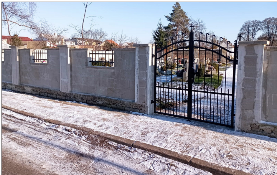
Nová zeď a vrata do urnového háje, foto: David Roháč
